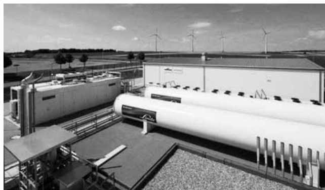
Figura 19, Immagine di un grande impianto per la produzione di idrogeno da elettrolisi. L'impianto, che ha una potenza di picco di 6 MW, è realizzato da Siemens, in collaborazione con l'utility elettrica locale e con l'Università di Rhein-Main; impiega la tecnologia di membrana a scambio protonico (PEM). https://www.key4biz.it/eolico-in-germania-il-piu-grande-impianto-di-elettrolisi-al-mondo-alimentato-con-il-vento/125008/
