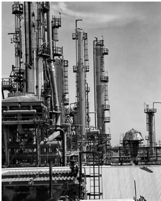
Figura 11, Vista panoramica di un impianto Reforming per la produzione di idrogeno industriale negli Stati Uniti. Fonte US Department of energy: https://www.energy.gov/eere/fuelcells/hydrogen-production-natural-gas-reforming
